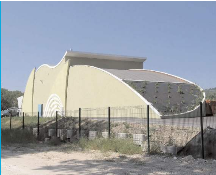
Bâtiment recevant les infrastructures techniques de la station intercommunale d'épuration.
